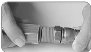
1. Rosqueie o adaptador junto à mangueira metálica flexível. Para auxiliar na vedação, utilize pasta vedante.
