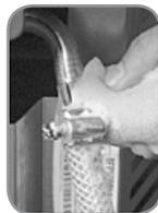
7. Após a instalação, verifique se há vazamento de gás, abrindo o registro de gás e colocando um pouco de espuma de sabão em todas as conexões que foram manuseadas. Se houver formação de bolhas, feche o registro regulador e refaça a operação ou consulte a **Rede de Serviços Brastemp**.
